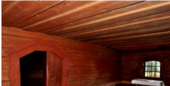
Потолок в трапезной из досок "в нахлест"
