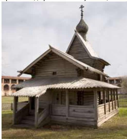
Кровля над трапезной и гульбищем
