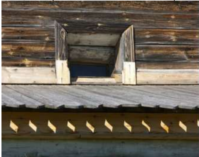
Косячатое обрамление волокового окна четверика
