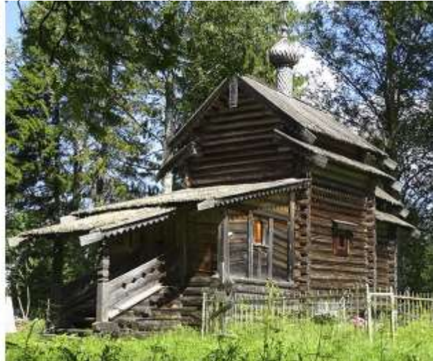
Кровля над притвором и крыльцо
