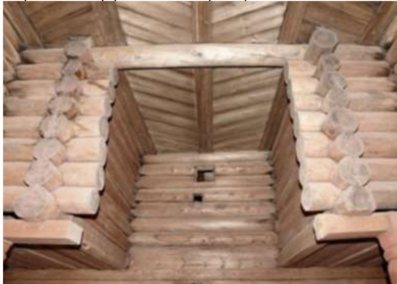
Вырезанная внутренняя стена притвора
