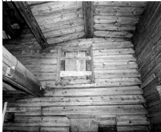
Двускатный потолок в молельной
