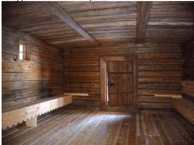
Вспарушенный потолок в трапезной
